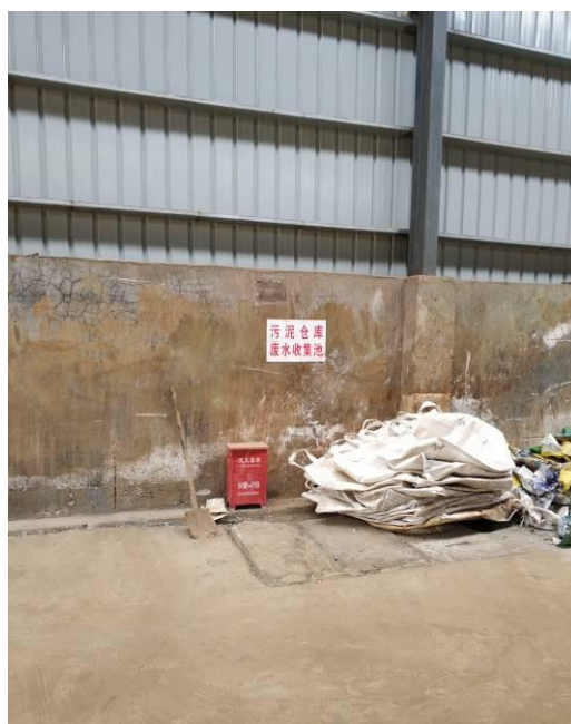
危废仓库废水收集池
