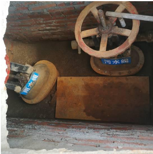
雨水总阀及废水阀门
