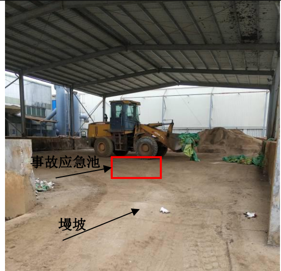
事故应急池及污泥中转仓埧坡
